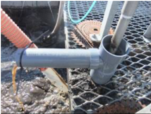
図 14. 塩ビ配管材で製作した水封器
