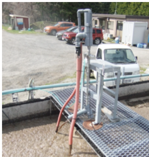
図1. MLSS モニタの構造および設置状況
