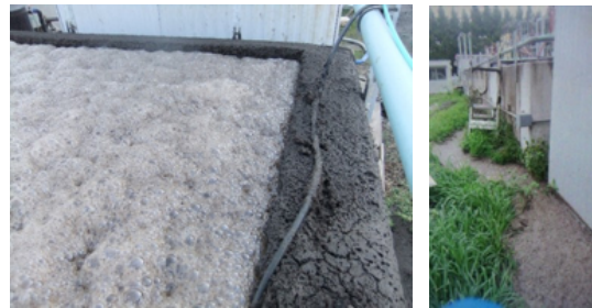
図1. 異常発泡による曝気液越流事例
